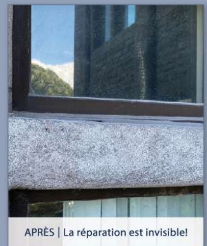
PENDANT | Nettoyage & réparation adéquate en cours
